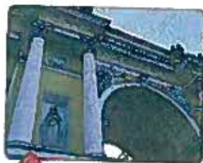
Здание Сената и Синода. Санкт-Петербург.
